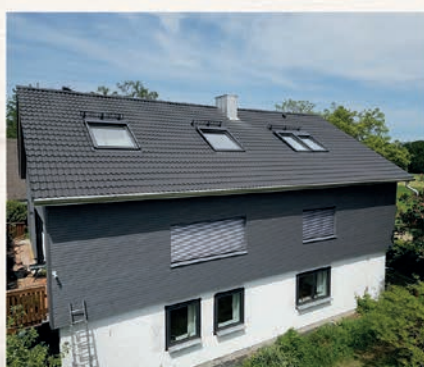
energetische Sanierungen für Dach und Wand, Fassadenverkleidungen
